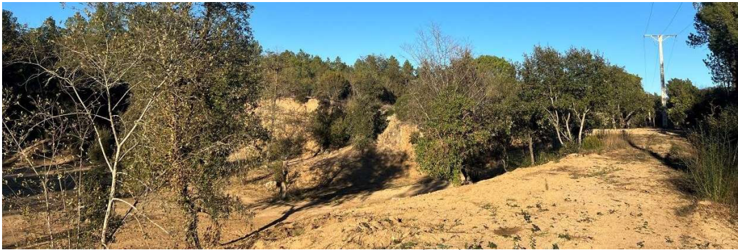
ESTAT DE NETEJA DE L'ESPAI ANNEX A LA BASSA SOBRE LA MOTA DE TERRENY I LÍNIA ELÈCTRICA ESTADO DEL ESPACIO ANEJO A LA Balsa SOBRE LA MOTA DE TERRENO Y TENDIDO ELÉCTRICO
