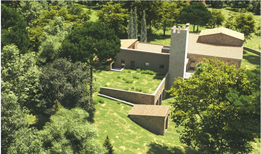
VISTA DES DEL SUD-OEST DE CAN MERCADER VISTA DESDE EL SUROESTE DE CAN MERCADER
