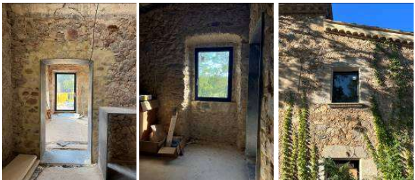
SUBSTITUCIÓ DE FUSTERIES EXTERIORS SUSTITUCIÓN DE CARPINTERÍAS EXTERIORES
