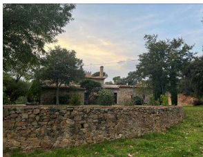
MUR ORIGINAL EN L'ERA MURO ORIGINAL EN LA ERA
