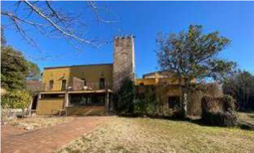
FAÇANA OEST FACHADA OESTE
