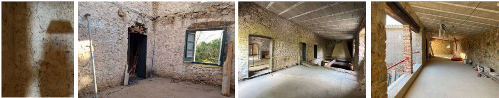
ESTRUCTURALS DE MAÇONERIA I FORJAT REPARAT GRIETAS EN MUROS ESTRUCTURALES DE MAMPOSTERÍA Y FORJADOS HORIZONTALES Y CUBIERTAS INCLINADAS REPARADAS
