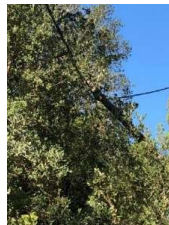
PAL D'ELECTRICITAT CAIGUT SOBRE MASSA BOScosa POSTE DE ELECTRICIDAD CAIDO SOBRE MASA BOScosa
