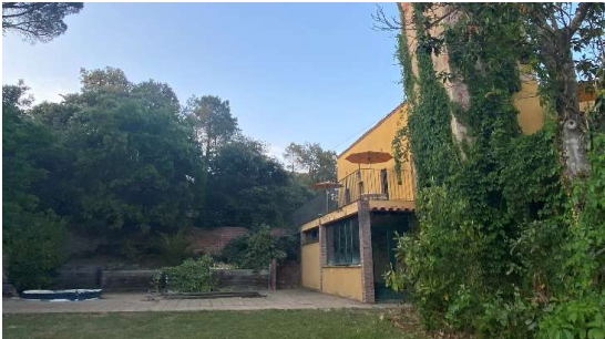
ESTAT ACTUAL. VISTA SUD DE LA UBICACIÓ DE L'AMPLIACIÓ PROPOSADA ESTADO ACTUAL. VISTA SUR DE LA UBICACIÓN DE LA AMPLIACIÓN PROPUESTA
